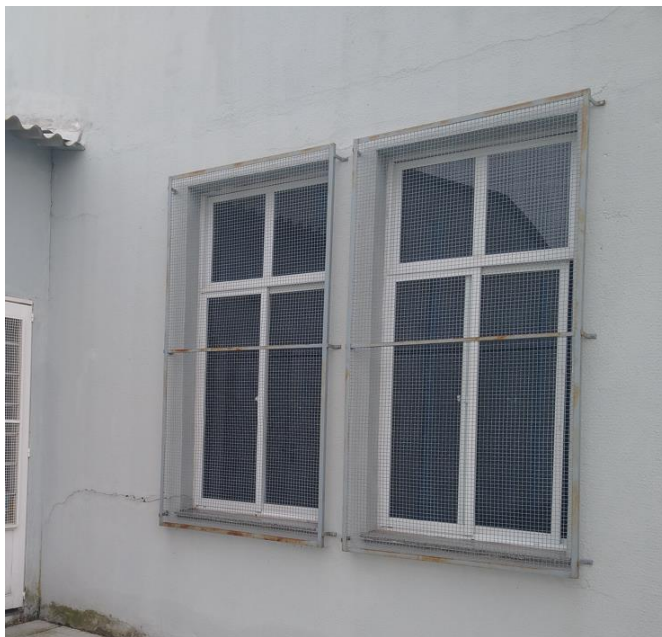
Figura 1 - Fissuras e rachaduras no entorno das esquadrias
