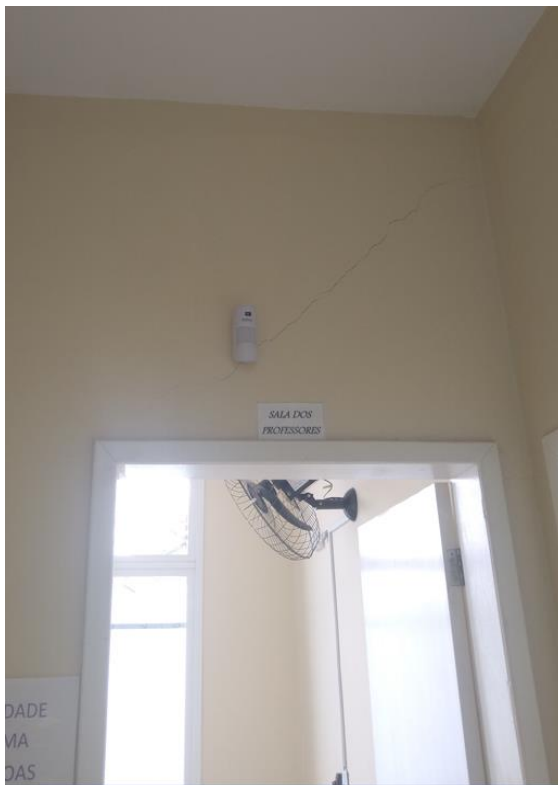
Figura 4 - Fissura diagonal em alvenaria
