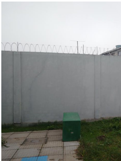
Figura 2 - Fissura em muro de divisa
