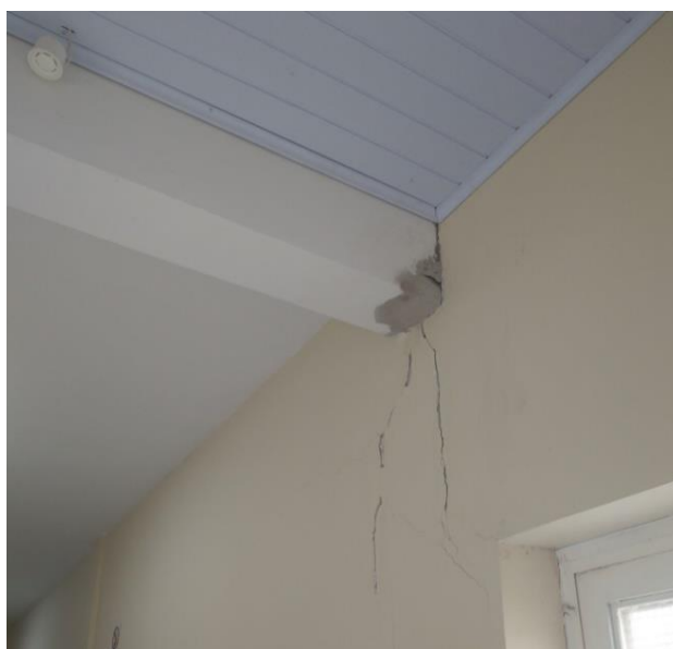
Figura 5 - Fissuras e rachaduras abaixo de viga
